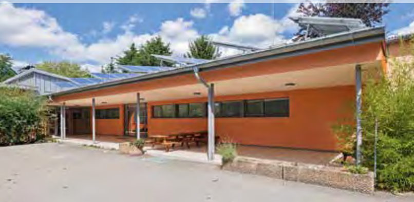
Panoramashule, überdachter Pausenhof
